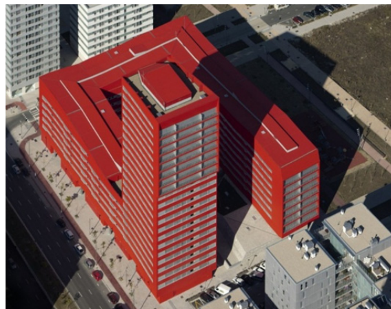
Figura 2. Vista aérea del edificio
