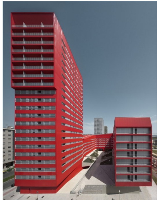
Figura 7. Vista fachada sur
